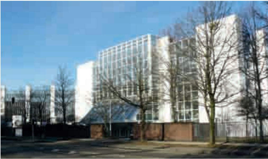
Der künftige Sitz des Bayerischen Landesamts für Statistik und Datenverarbeitung in der St.-Martin-Straße 47 in München. Das Gebäude bietet die erforderlichen Voraussetzungen für den Betrieb eines modernen Rechenzentrums.
