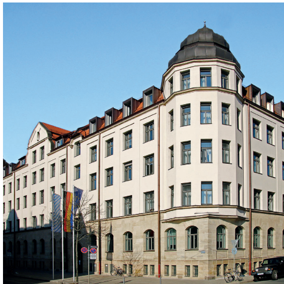
Dienststelle Fürth in der Nürnberger Straße 95
